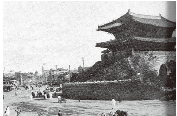
【図2】 左右の城壁が崩された南大門 37
