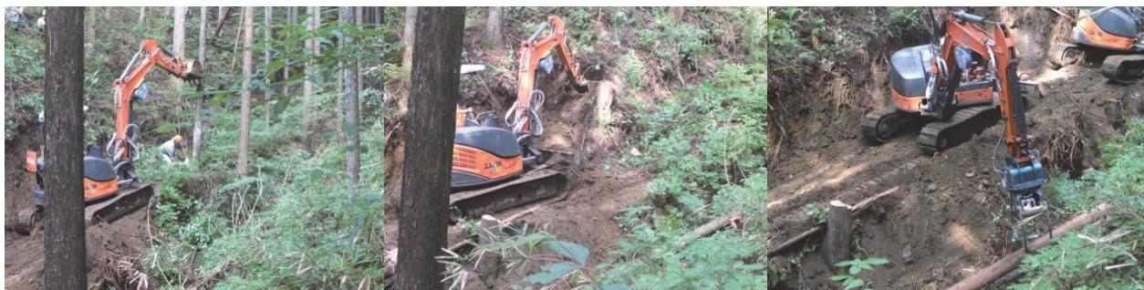
写真－3 間伐作業の作業道作設（左：支障木伐倒、中：グラップル付バックホウによる掘削、右：グラップル付バックホウによる集積）
