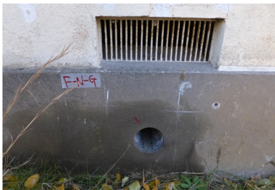
写真 3.2.1-1 基礎立上り部でのコア採取
