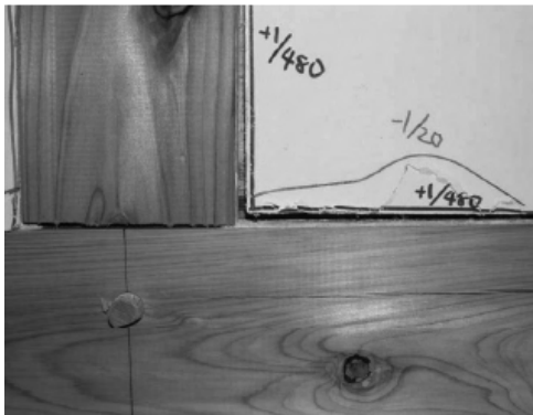
(b) 中柱柱脚部
