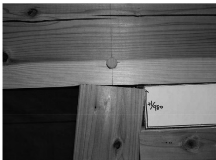
(b)中柱柱頭部
