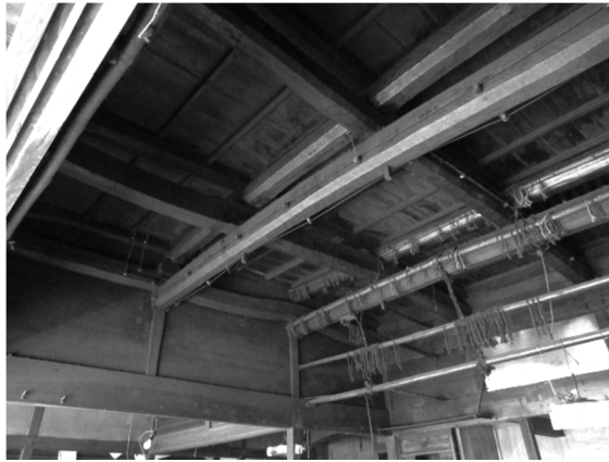
写真 16 か通り 5～11 通り差し鴨居 4 通り る～か通り差し鴨居
