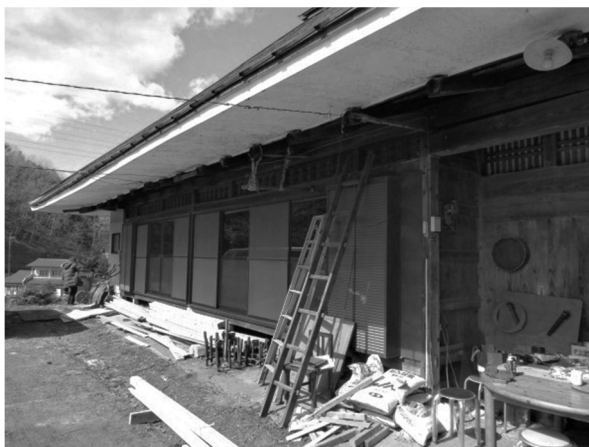
写真5 対象古民家南縁側外観(1)
