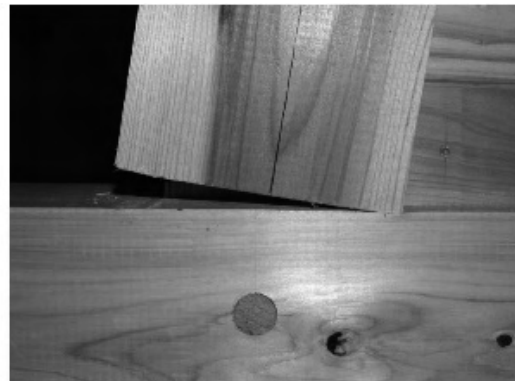
(e)中柱柱脚部
