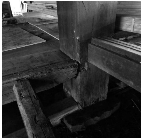
写真 12 り-5 大黒柱の石場建て
