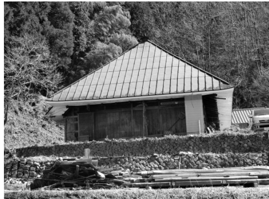
写真4 対象古民家西側外観
