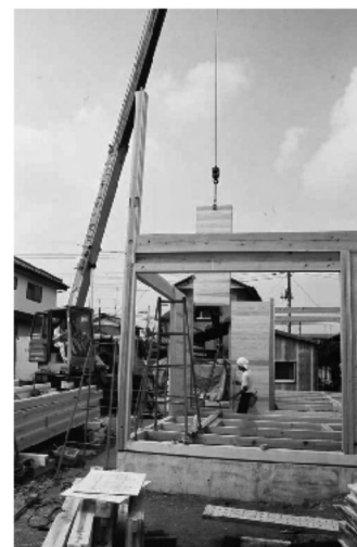
写真5 現場で壁パネルを組み込む
