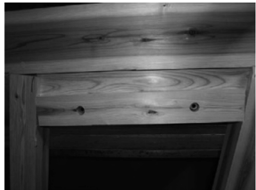
(b)差し鴨居の状況
