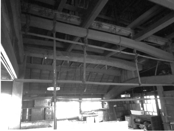
写真 22 5通り は〜り通り小屋梁
