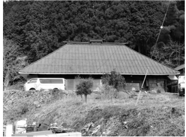
写真2 対象古民家南外観
