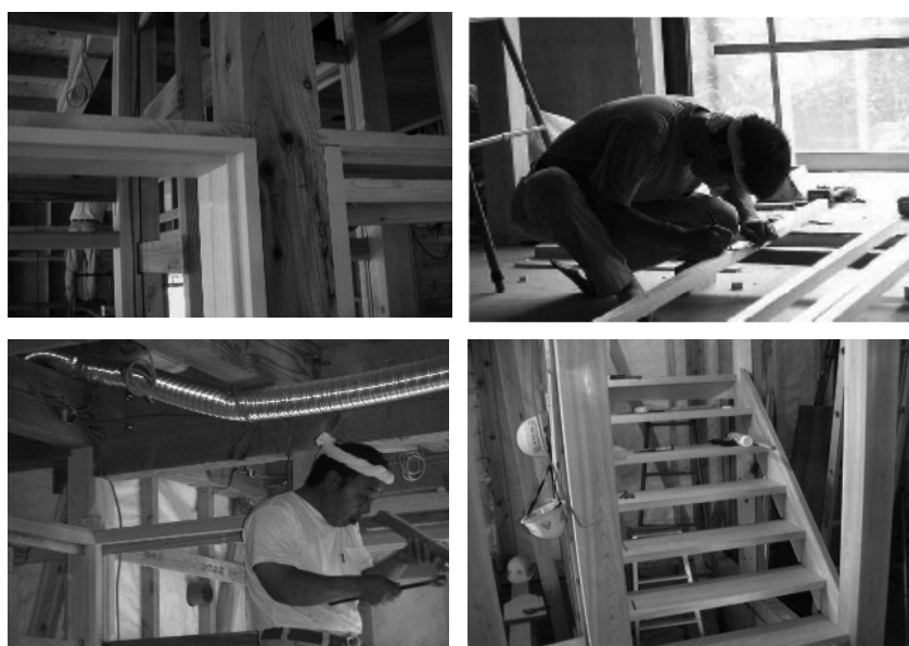
写真3 熟練大工の調整を要する現場の造作
