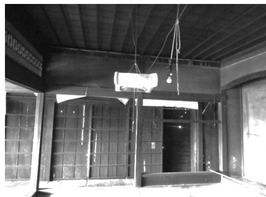
写真 21 そ通り 3～7 通り付け鴨居
