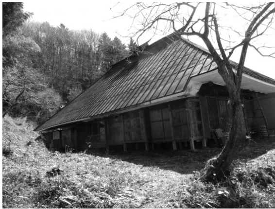
写真3 対象古民家西北外観
