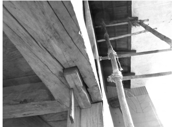
写真 29 そー7 柱柱脚部 足固め継手
