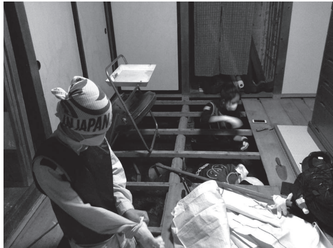
図2 ボランティアによる家屋床下の泥出し
