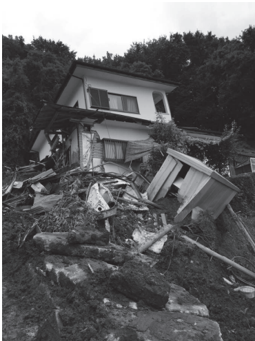
図1 土砂崩れにより倒壊した家屋
