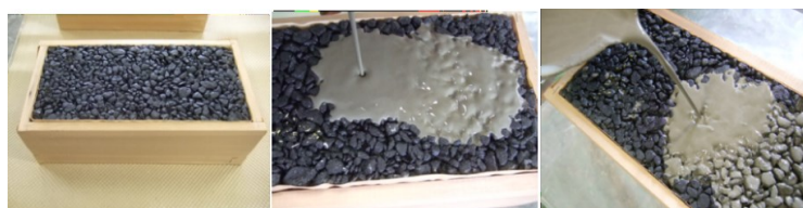
写真 - 3.6 高流動型半たわみ性舗装用充填材の充填状況
