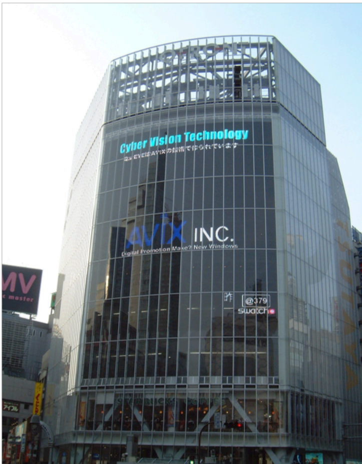
図 1.16 Qfront 外観：表示を出さない時は、ただのガラスのビルで、内部が見える構造となっている。
