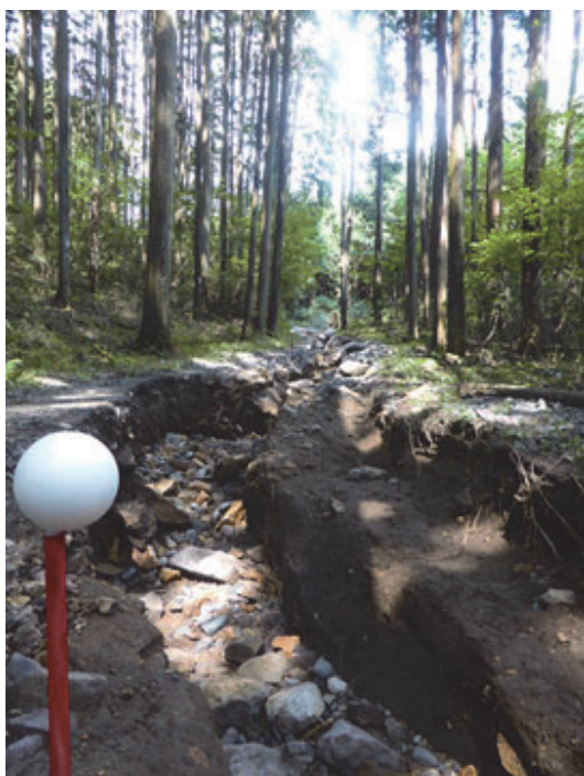
図 4 - 4 洗堀被害状況(6 林班ろ周辺)
