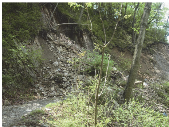
図 4-1-a のり面崩壊被害（7 林班）
