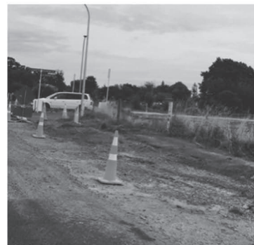
写真 3 液状化地区の様子（すべて筆者撮影）
