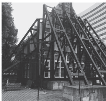
写真 2 補強されるゴシック様式の建築物
