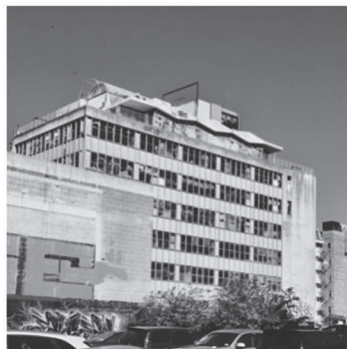
写真 1 取り壊されずに残される中層建築物
