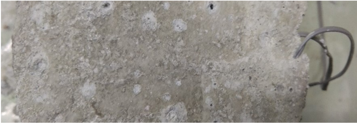
写真-5.6.11 塗布後3日が経過したひび割れの様子
