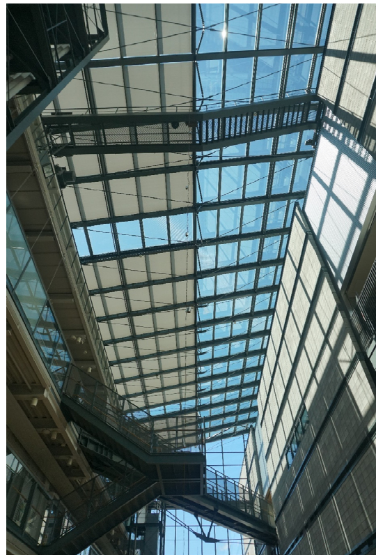
図 5-2-4 アトリウム内状況(2)
