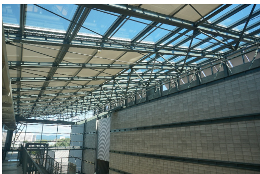
図 5-2-5 アトリウム内状況(3)
