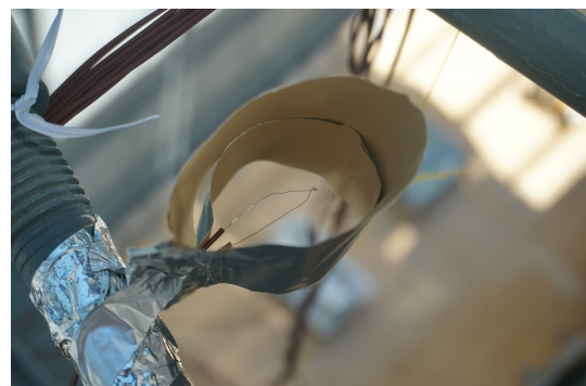
図 5-2-6 放射除け設置状況
