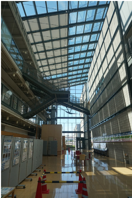
図 5-2-3 アトリウム内状況(1)
