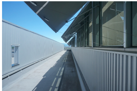
図 5-2-8 アトリウム頂部開口状況(2)
