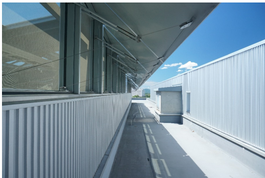
図 5-2-7 アトリウム頂部開口状況(1)
