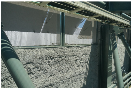
図 5-2-9 アトリウム頂部開口(内観)
