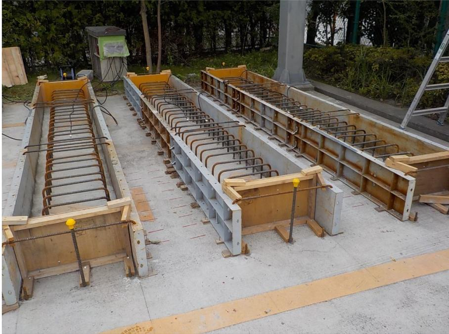
写真-6.4 簡易模擬部材の型枠および鉄筋の配置状況
