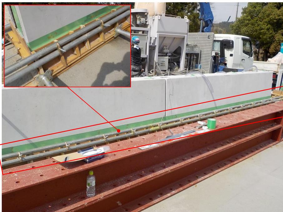
写真-6.10 試験施工した実部材（赤線囲い部がモルタル注入部）
