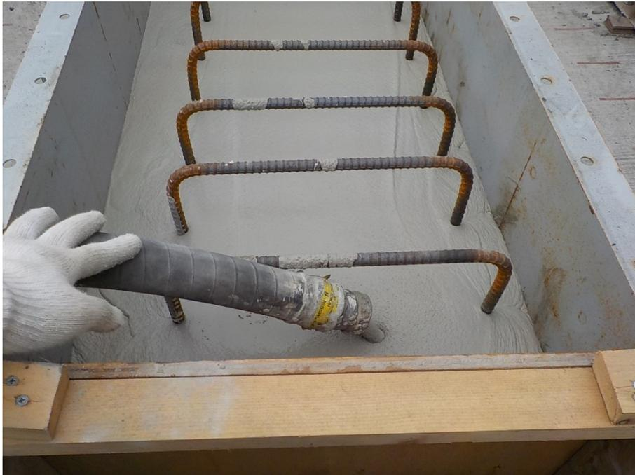
写真-6.5 模擬部材への充填状況
