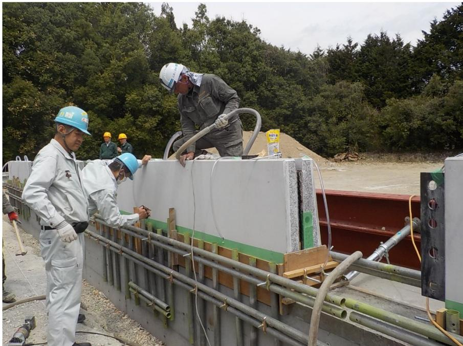
写真-6.11 モルタル材の注入状況
