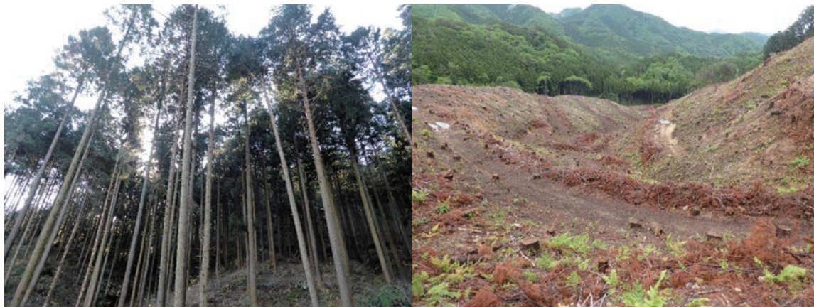
写真－3 調査地 E の作業前（左）と作業後（右）
