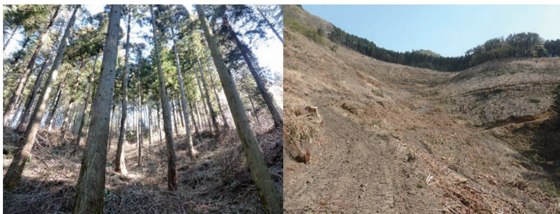
写真－2 調査地 D の作業前（左）と作業後（右）
