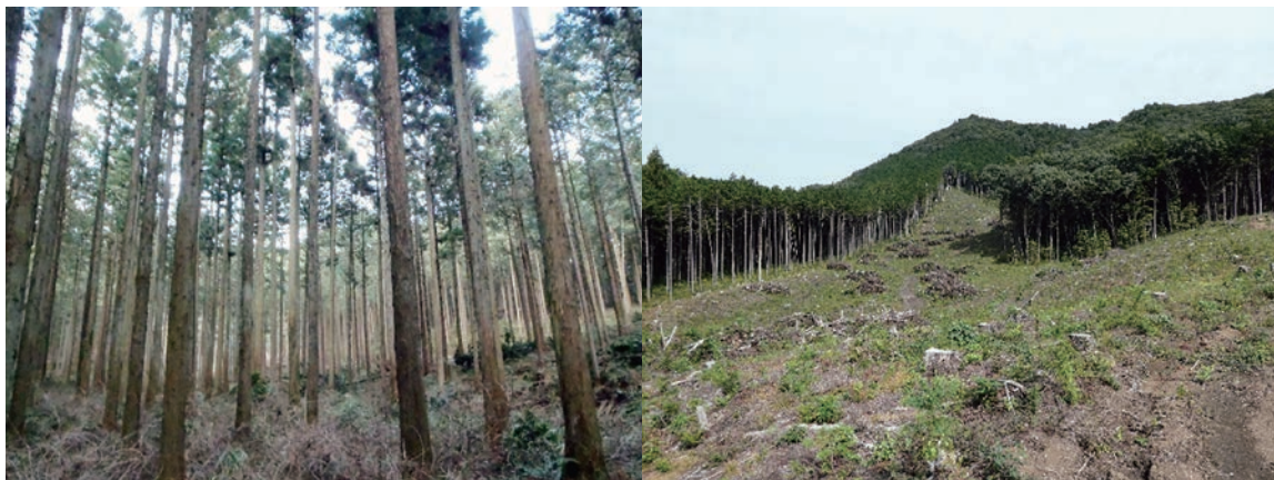
写真-1 調査地 C の作業前 (左) と作業後 (右)
