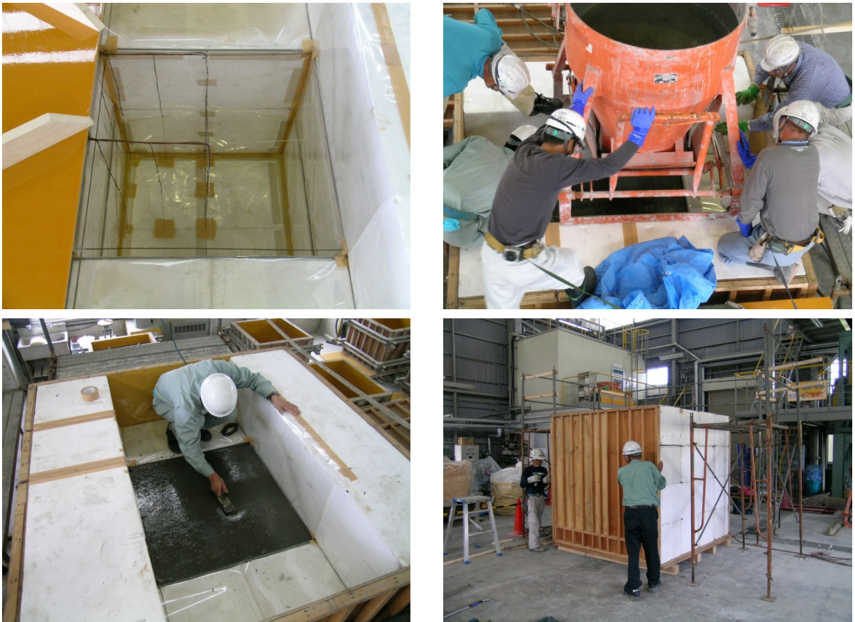
写真 3-2 マスブロック試験体の製作状況
