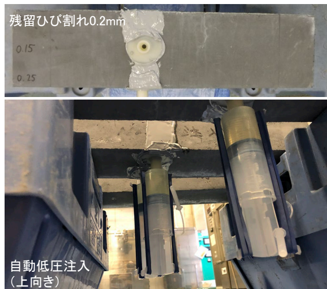
写真 7-1 ひび割れ注入状況
