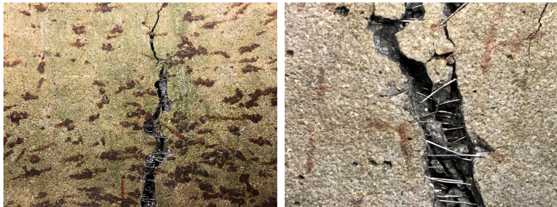
写真 6-6 静的曲げ試験後の破壊面（繊維残存）
