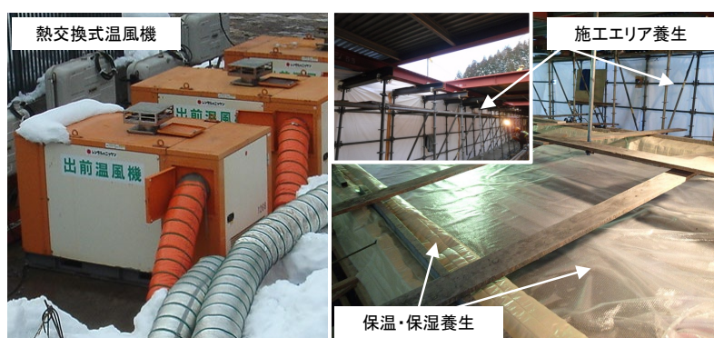
写真4-6 給熱養生状況
