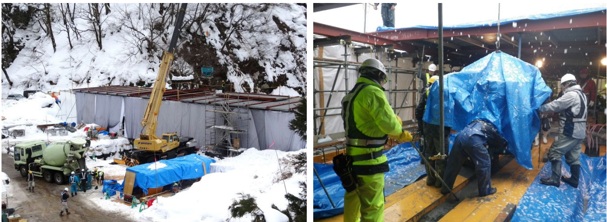
写真 4-2 主桁の打込み状況
