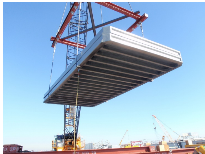
写真 1-1 羽田空港 D 滑走路への UFC 床板の適用 (筆者は床板製作工場にて管理者として赴任)
