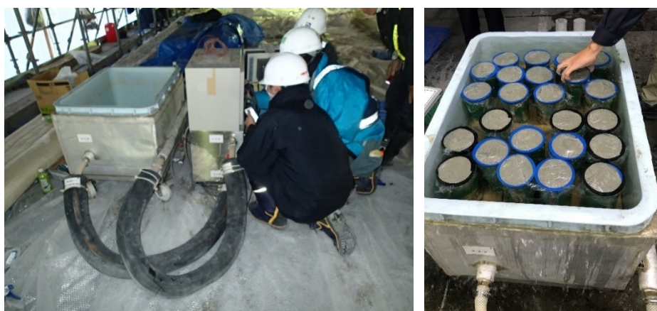
写真4-7 管理用圧縮供試体の養生状況(温度追従養生層)
