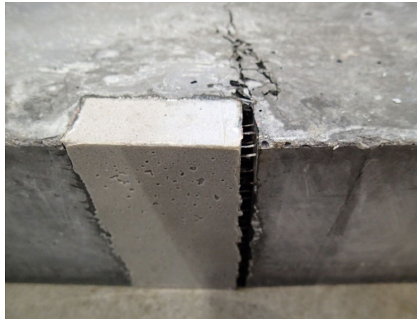
写真 7-9 断面補修界面の繊維架橋状況(静的曲げ試験後)
