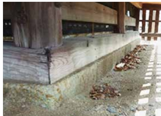
写真9 延命院地蔵堂の大谷石の基礎
