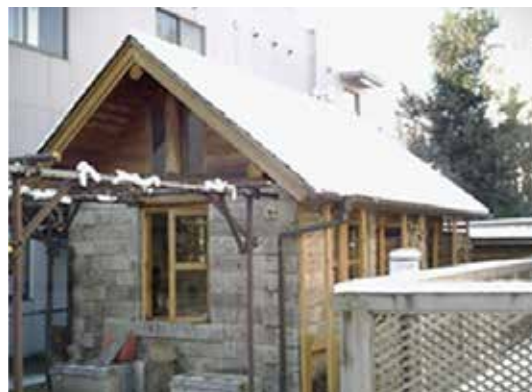
写真4 完成直後の自作工房
