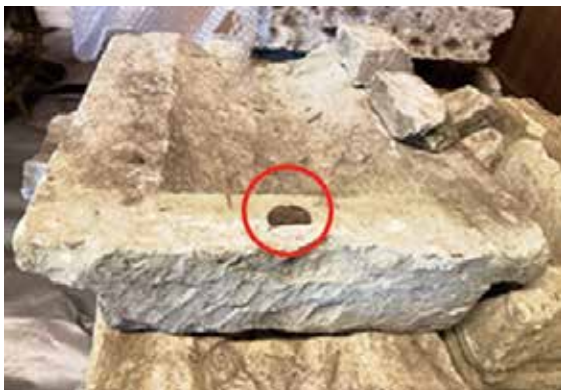
復元された書蔵内に保存されている石屋根の上石 固定には和釘が使用されている（写真2）
