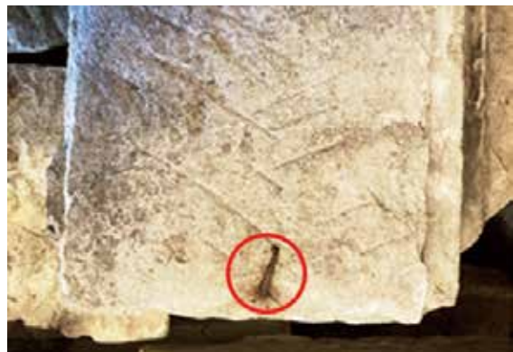
上石の裏側 和釘だとはっきり判る 釘先を曲げてあるのは解体後と思われる（写真3）
