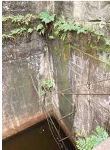
竪坑跡①別角度
