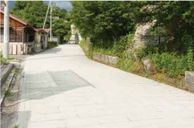
新大谷石で舗装し直された歩道
