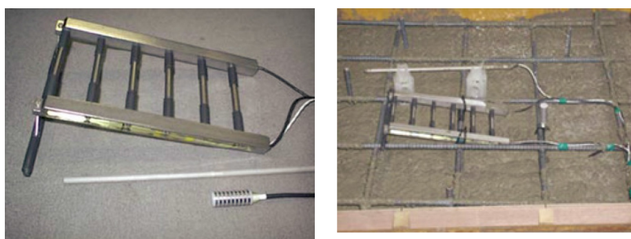
図 2-4 アノード・ラダー・システムと設置状況
