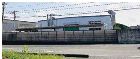
写真1. 日光石材(株)の仁良塚の社屋・加工所（宇都宮市宝木本町）の場所、かつての日光石材(株)の面影はない
