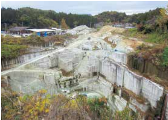
写真46. 現大谷石採石場 (露天掘り)
