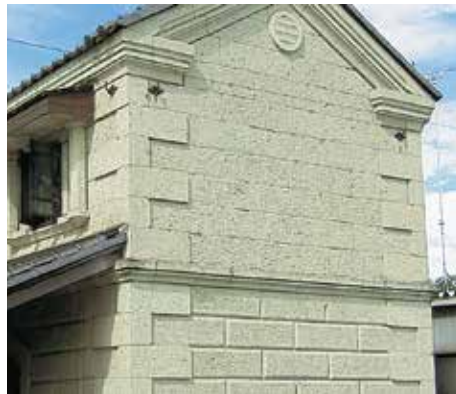
写真38. 桜田石石蔵（昭和29年）
