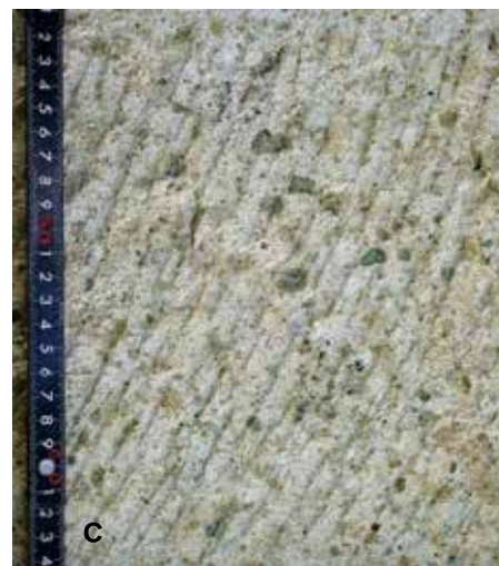
図19. 西根の池田家の徳次郎石石蔵（a）、薄黄白色の火山礫凝灰岩の張り石（b）、およびその張り石の表面の拡大（c） 緑色から褐色の火山岩の角礫～亜角礫が含まれる。張り石を固定する釘は漆喰で隠れている。
