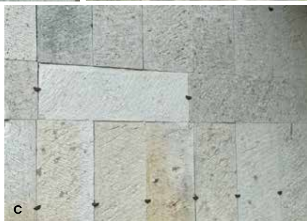
図18. 上田中の池田家の徳次郎石蔵（a）、青灰色の火山礫凝灰岩の石柱（b）、および緑灰色の火山礫凝灰岩の張り石（c） 緑泥石化した火山岩円礫が顕著に含まれる。
