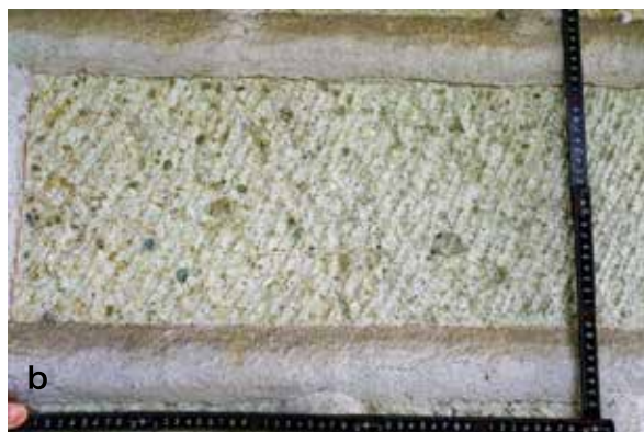
図19. 西根の池田家の徳次郎石石蔵（a）、薄黄白色の火山礫凝灰岩の張り石（b）、およびその張り石の表面の拡大（c） 緑色から褐色の火山岩の角礫～亜角礫が含まれる。張り石を固定する釘は漆喰で隠れている。
