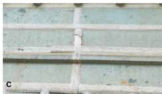
図17. 上田中の池田家の徳次郎石蔵（a）、青灰色の火山礫凝灰岩の積み石（b）、および緑灰色の火山礫凝灰岩の積み石（c） 緑色の火山礫が顕著に含まれる。
