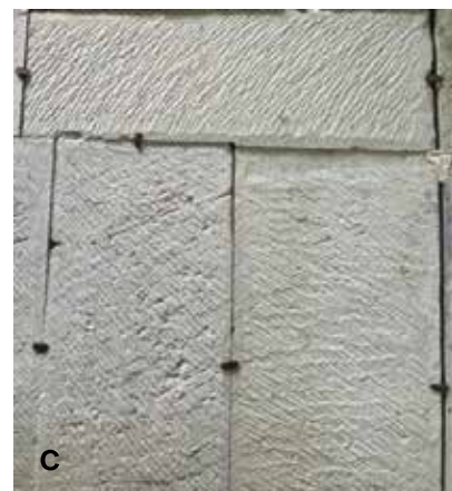
図16. 門前の大房家の徳次郎石石蔵 (a)、白色の細粒凝灰岩の張り石 (b)、および灰白色の細粒凝灰岩の張り石 (c)
