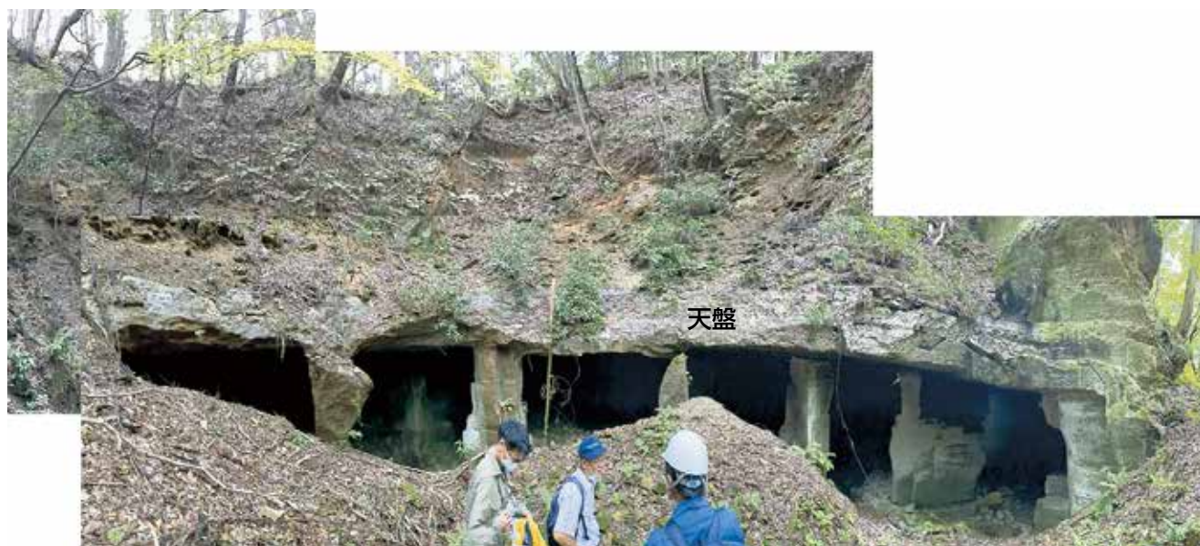
図2. 田中場南の徳次郎石採石場跡の開口部。天盤の灰色細粒凝灰岩がゆるく東に傾斜する。
