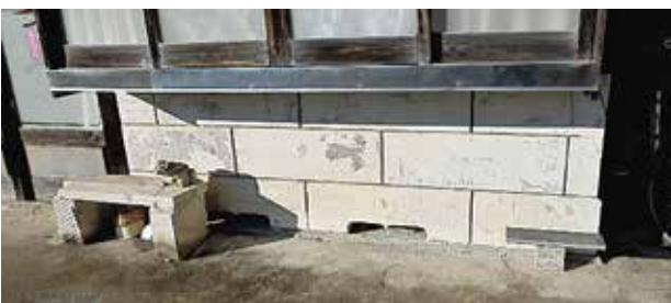
写真18. 船生石は地域では土台の使用が見られる 船生 沼倉 斎藤庄司 宅
