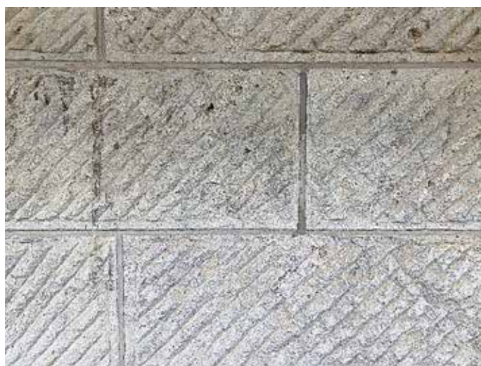
石蔵② 1階壁面
