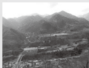
足尾銅山 本山製錬所
