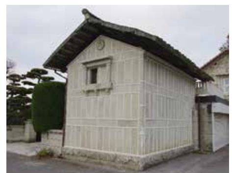
写真6. 桜田石の貼石蔵
