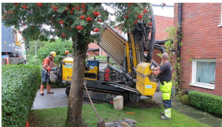
図 4.12 スウェーデンの一般家庭の庭で地中熱ヒートポンプの設置を行っている様子
