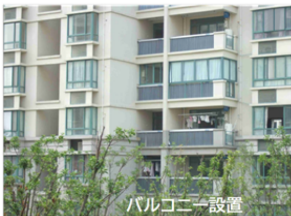
図 4.11 中国の一般家庭のバルコニーで太陽熱システムが設置された様子
