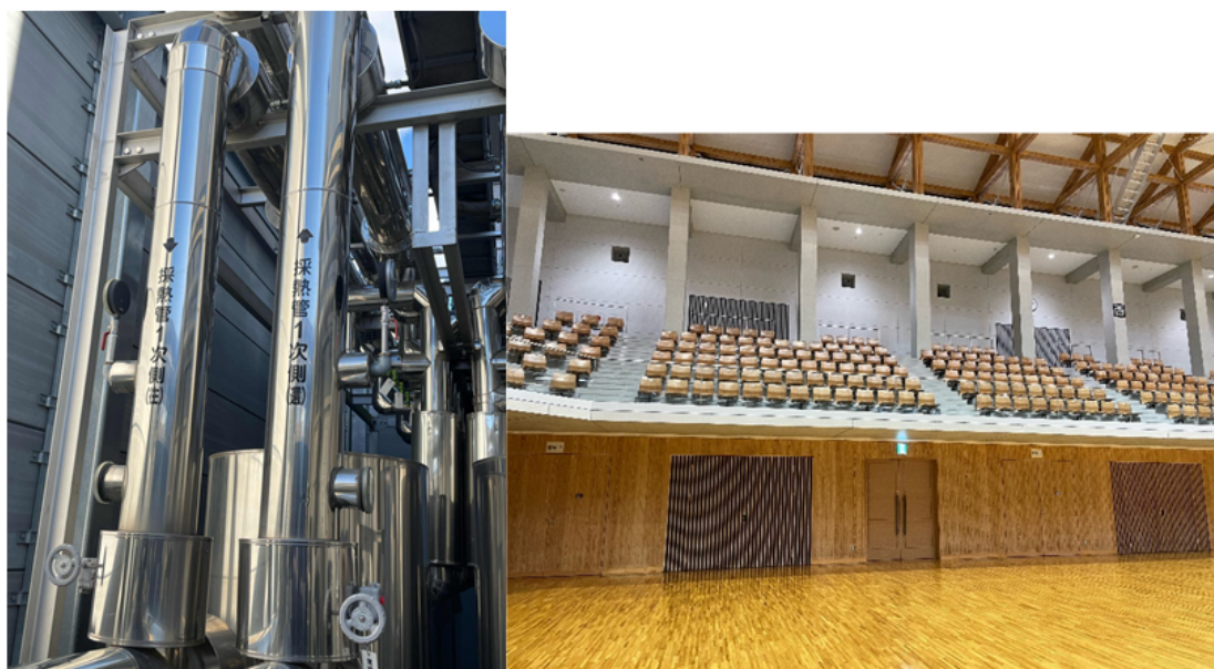
図 4.15 「ユウケイ武道館」館内と採熱管の様子
