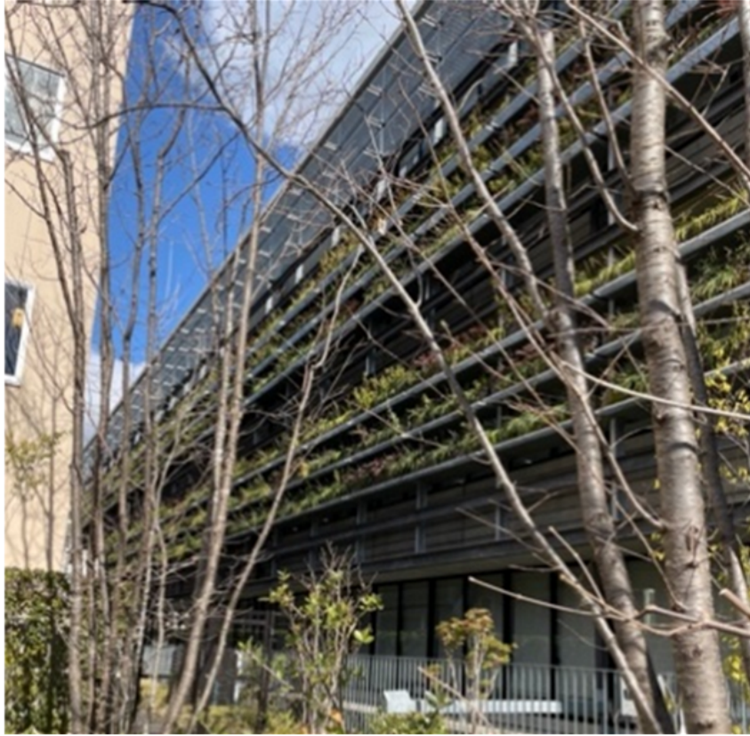
図 5.13 京都市役所分庁舎 壁面緑化の様子
