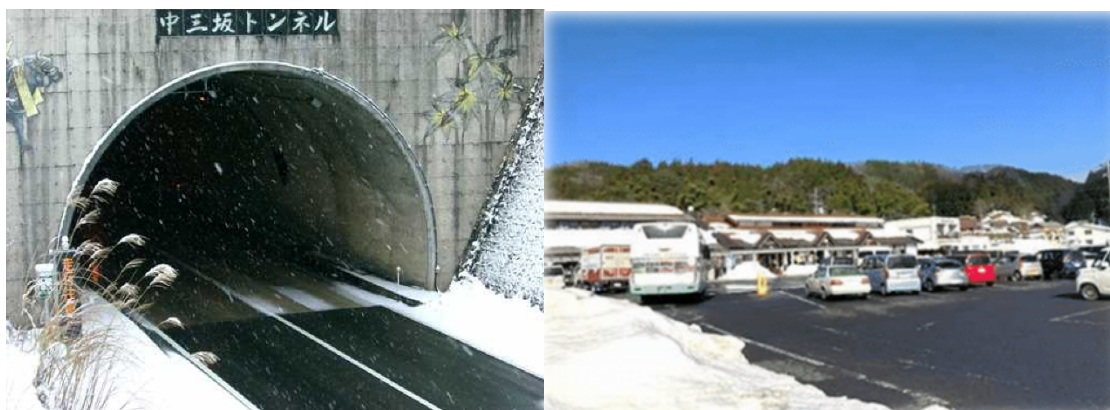
図 4.13 島根県邑南町地中熱融雪設備の融雪状況（左）と瑞穂駐車場で地中熱設備を導入した後の様子（右）
