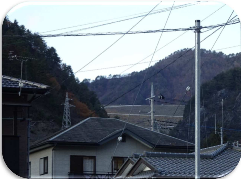
町内から臨む箕子橋堆積場。山間の谷にダムを建設して堆積場にした。(2018年11月17日)
