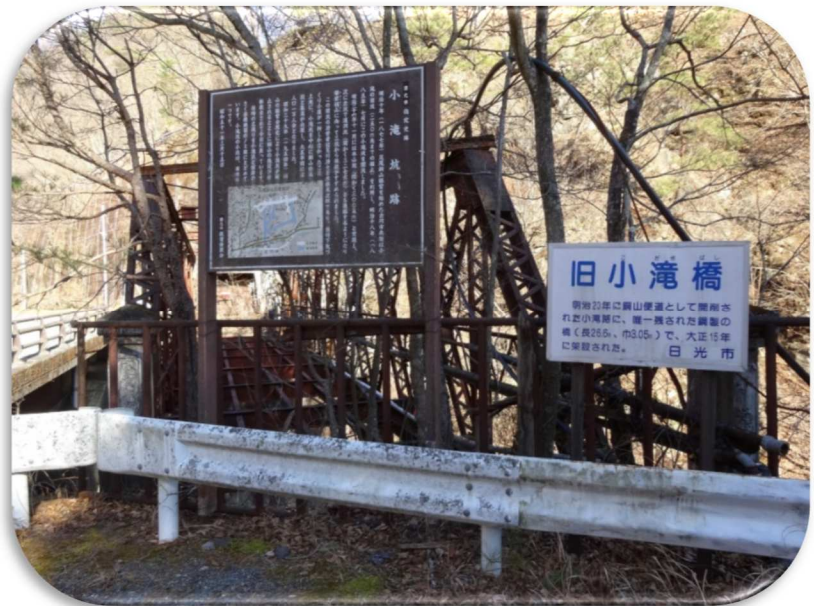
日光市指定史跡の旧小滝橋。橋の向こう側に小滝坑がある。 (2019 年 12 月 13 日)
