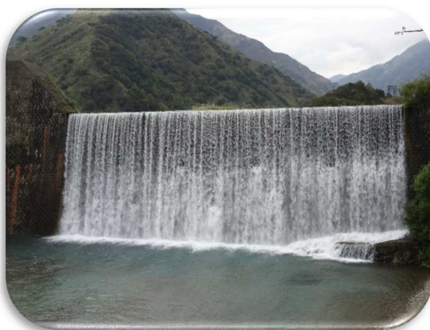
松木・足尾砂防堰堤。 渡良瀬川へ土砂が流 出しないように堰き 止めている。 (2019年12月13日)
