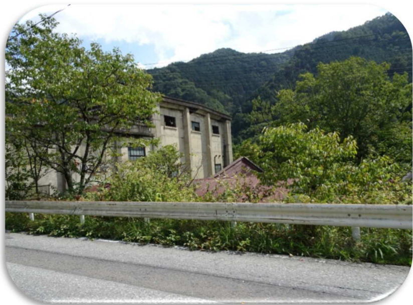
現在も稼働している通洞変電所（2017年6月17日）
