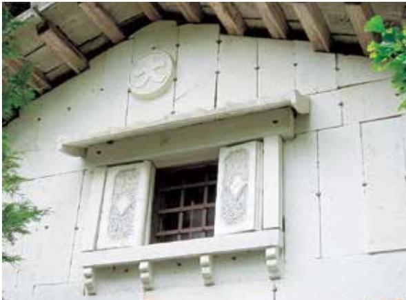
写真2. 張り石蔵 (外部補強型)
