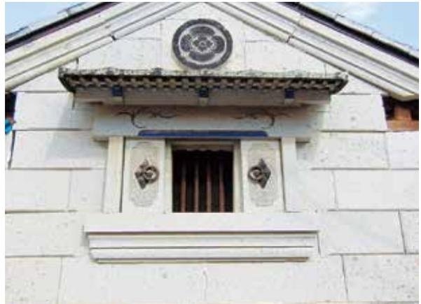
写真3. 張り石蔵 (内部補強型)
