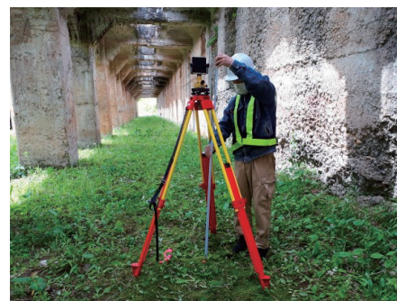
写真 9 TLS 用ターゲットの設置 （森田撮影）
