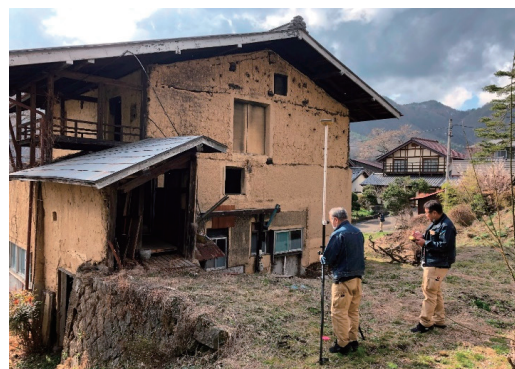
写真5 GNSS 測量観測の様子 (鈴木撮影)
