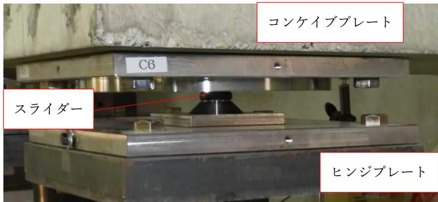
写真-2.2 シングル球面すべり支承 (設置状態)
