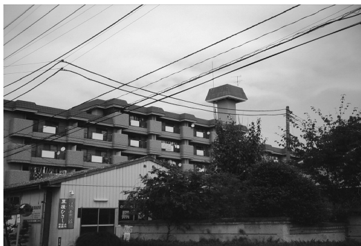
写真 1-5 マンションの上にきこみみたいなもの。
