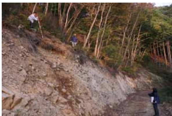
図-2.5 横断測量の様子
