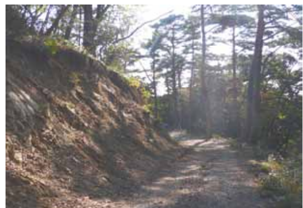
図-3.11 基幹林道終点付近の状況
